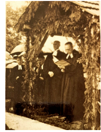
Pfarrer Dr. Weichlein bei der Grundsteinlegung.
